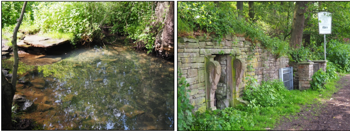
Bild 8 Einleitestelle am Stollenbach und Fahrtschacht/Gezähkekammer Schlebuscher Erbstollen in Wetter-Oberwengern (Schöpel Mai 2019)
